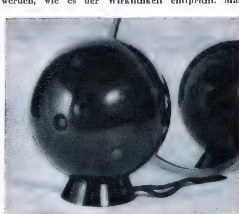
Bild 2 b. Der Kunkopf mit den beiden Mikrofonen.
